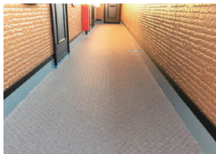
マンション共用部シート工事
