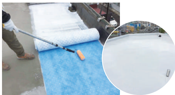
各種防水工事
