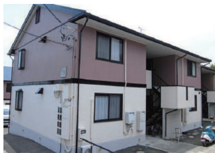
アパート外装塗装工事
