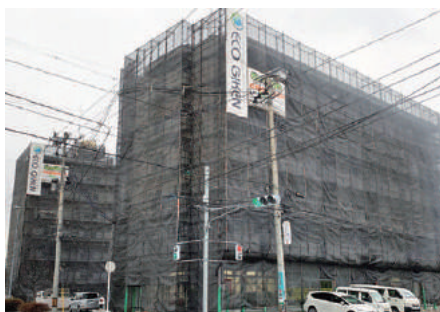
マンション大規模改修工事
