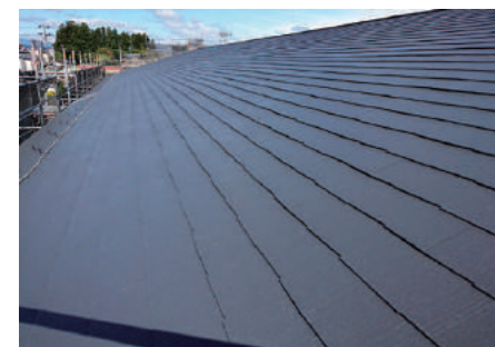
屋根塗装工事
