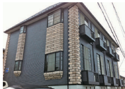
アパート外装塗装工事
