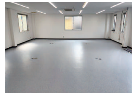
事務所内装工事
