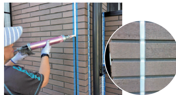
シーリング工事
