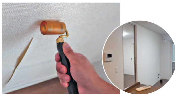
内装仕上工事
