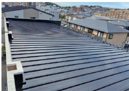
屋根塗装工事
