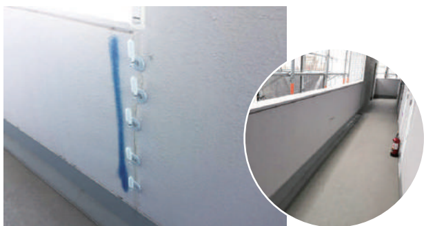
各種注入・補修工事
